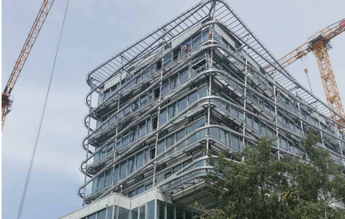
▲ Sekundární ocelová konstrukce s úpony pneumatické fasády ETFE
