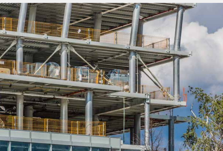
▼ Hlavní nosné sloupy ve ztraceném bednění z tenkostěnných ocelových trubek jsou vybetonovány
